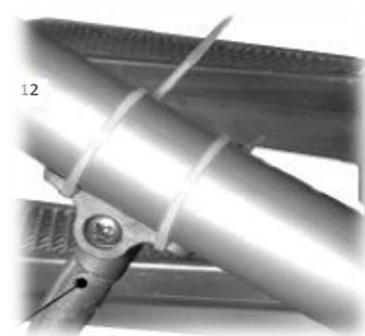
Posez maintenant les tronçons de tube de la main courante sur les supports de la main courante en commençant par le bas. Servez-vous de colliers plastique de serrage d'au moins 14 cm de longueur pour la fixation provisoire des éléments. Déterminez vous-même le dépassement du tube vers le bas.
